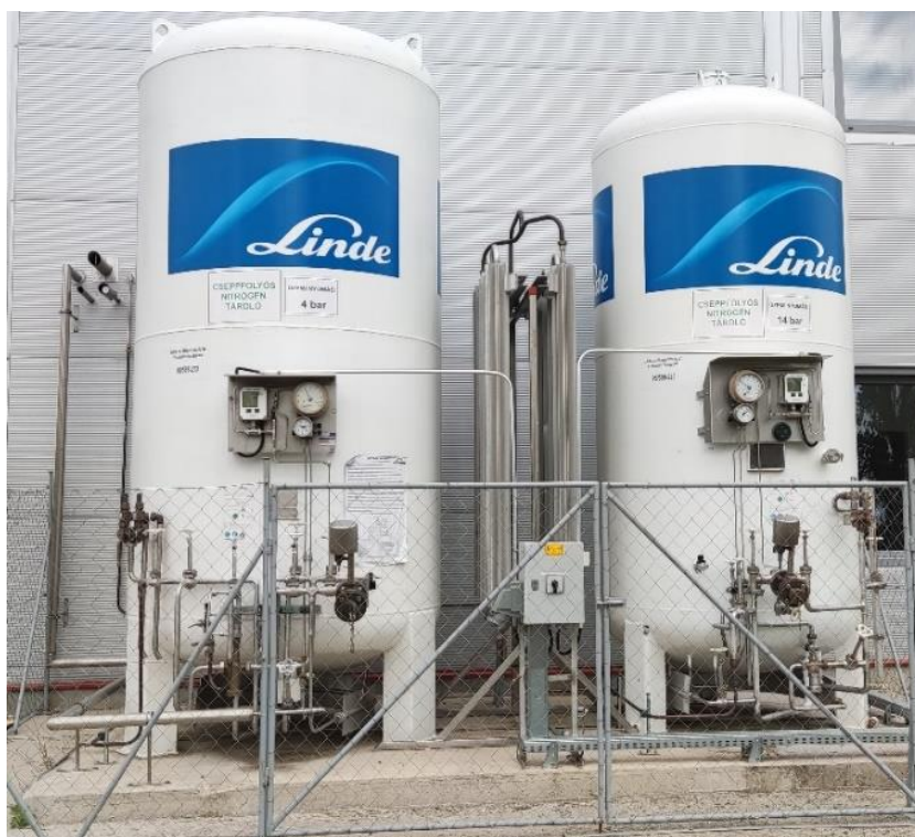
19.ábra. Cseppfolyós nitrogén tárolók a Titán 94 Kft -nél, bal (4 bar) cseppfolyós alkalmazáshoz, jobb (14 bar) gáz halmazállapotú használatra [18]
