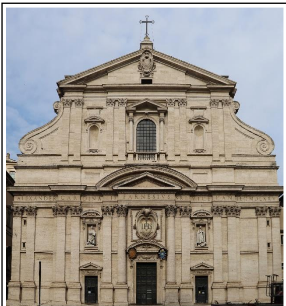
2. Az Il Gesù homlokzata
