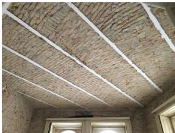
2. ábra: Megépült poroszsüveg födém (fotó: Kvarc Építész Stúdió)
