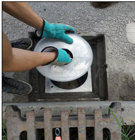
4. ábra Szűrő telepítése (Urbán B. et al., 2021)
