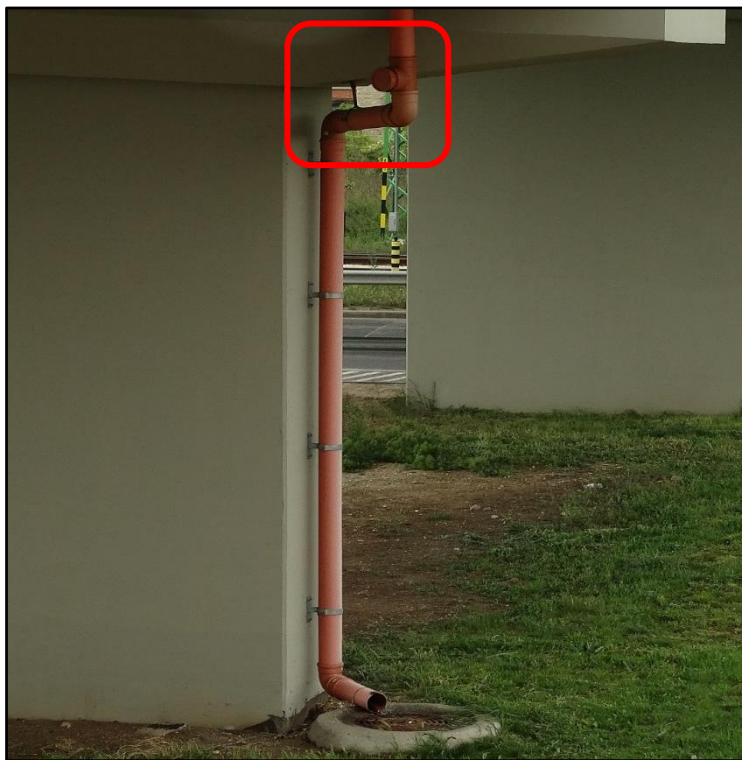
19. ábra Ülepítő berendezések tervezett helye
