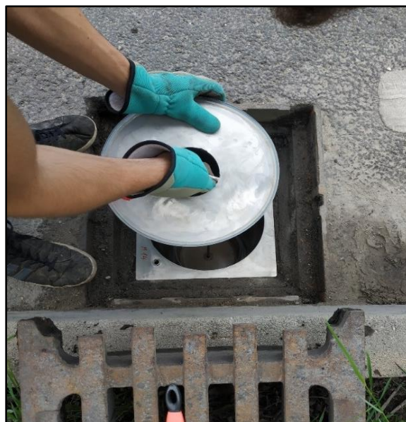
4. ábra Szűrő telepítése (Urbán B. et al., 2021)
