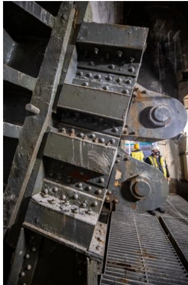
12. ábra: Lehorgonyzó láncköteg a felújítás előtt [10].
