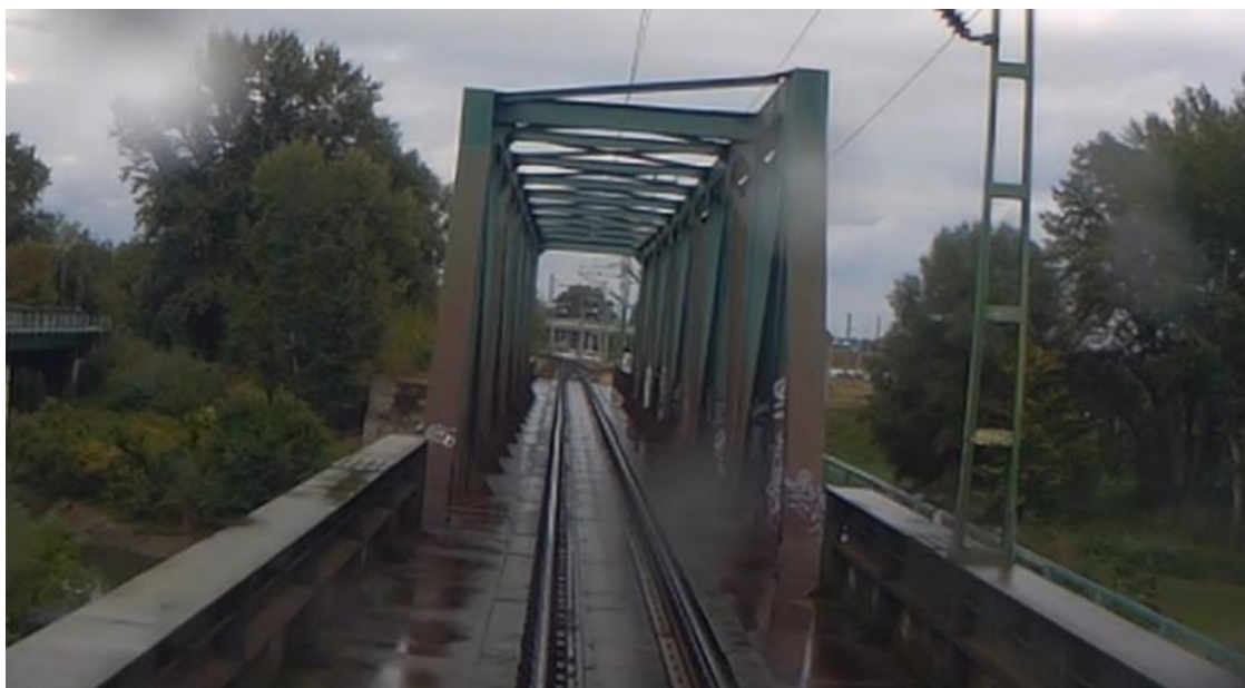
1. melléklet 26. ábra: Vasúti felüljárón való áthaladás
