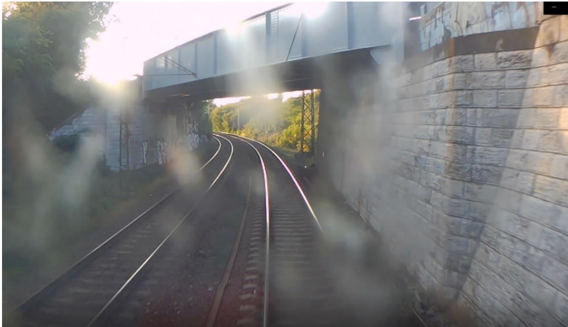
1. melléklet 50. ábra: Villamos felüljáró alatti elhaladás
