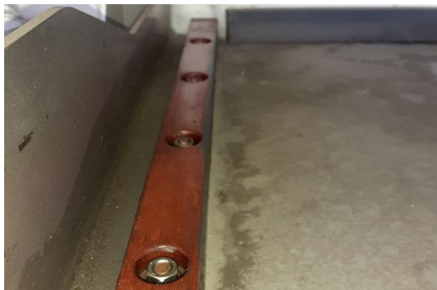
37. ábra: A klímaberendezésének cseréjét megkönnyítő csúszóbetétes sín
