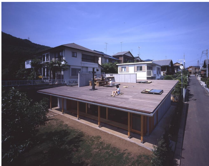
12. kép: Tezuka Architects, Roof House, tömeg
