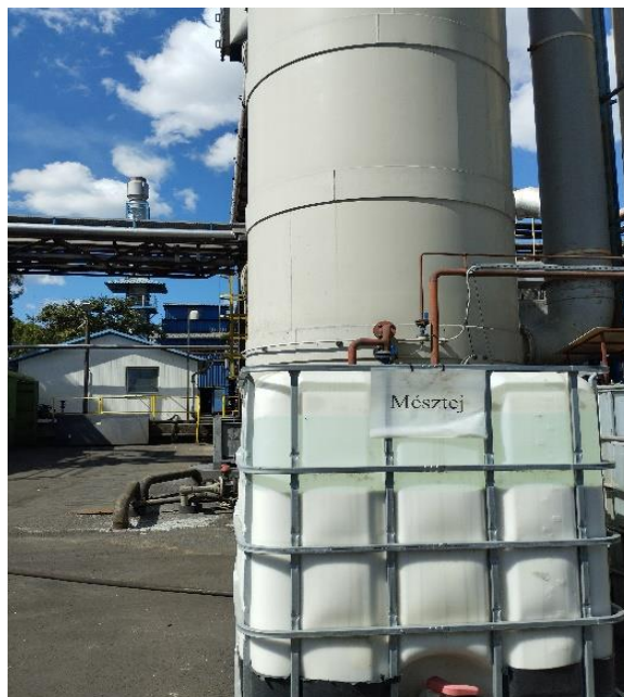
9. ábra: A veszélyes hulladék égetőmű mésztej adagolása [Saját készítésű kép].
