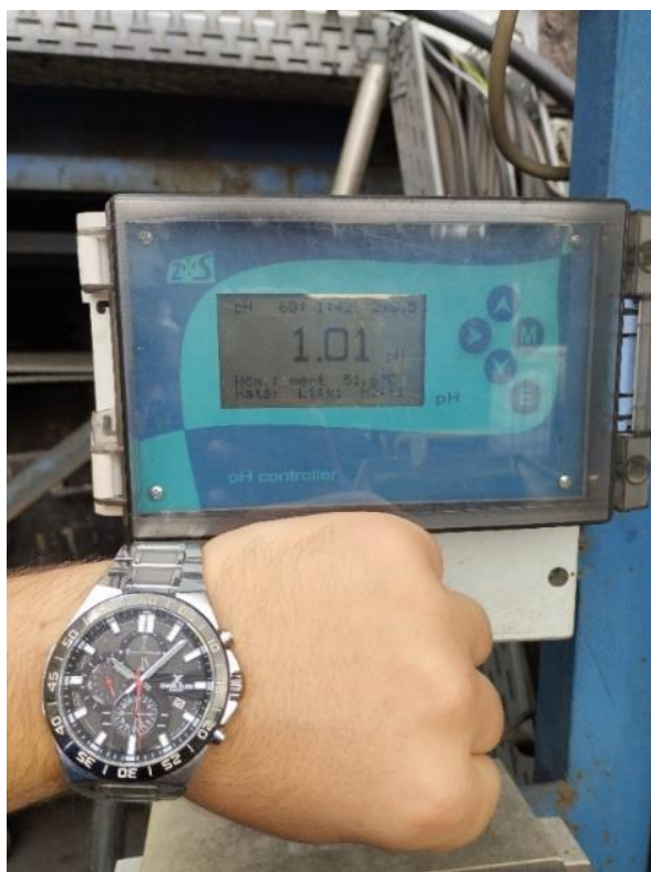
10. ábra: A savas mosótorony pH szintje [Saját készítésű kép].
