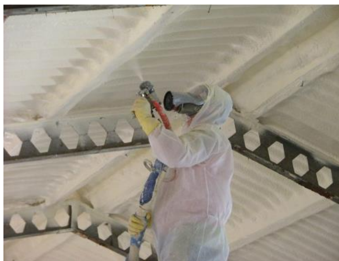
9.ábra: szórt PUR szigetelés [13]
