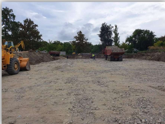
1.5. ábra: Medence bontása; Zúzott beton ágyazatként való felhasználása, Vasbeton medence - darált beton [saját fénykép]
