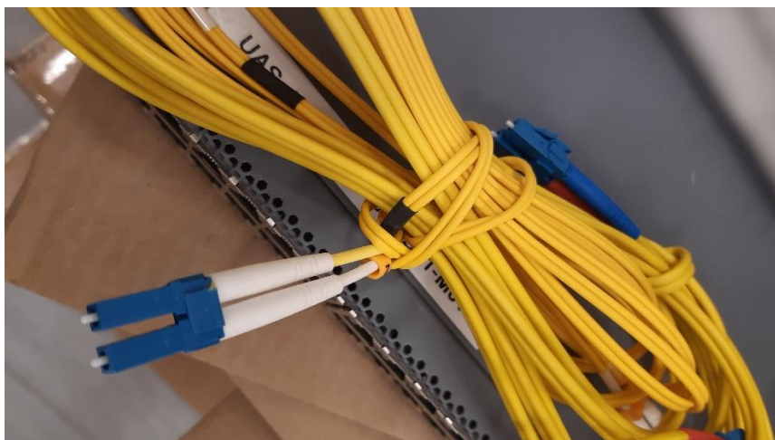
21. ábra: Különösen rossz módon tárolt optikai patch kábel
