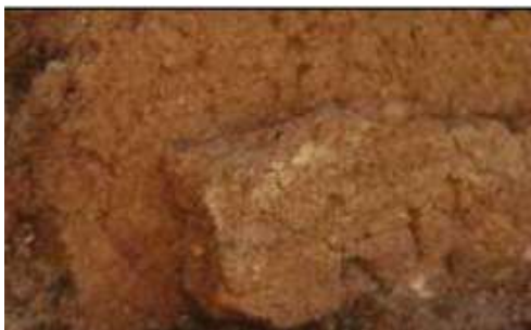
10.Kép. Kétrétegű sárvakolat oldalfalon. Gorsium , XCLV. épület. (fotó: Harsányi Eszter – kurovszky Zsófia).
