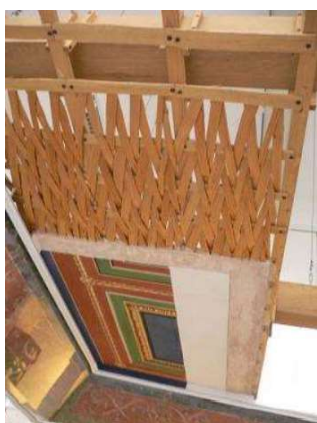
15.Kép. Lécekből font könnyűszerkezetes mennyezet rekonstrukciója. Augusta Treverorum Gallia Belgica, Trier. (fotó: Krusovic Zsófia).
