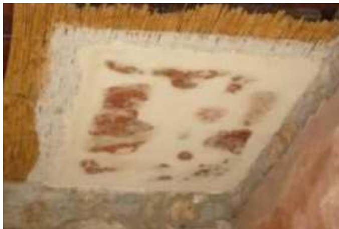
14.kép. Rekonstruált nád stukatúr mennyezeten. Casa del Menandro, Pompeii . (fotó: Harsányi Eszter).
