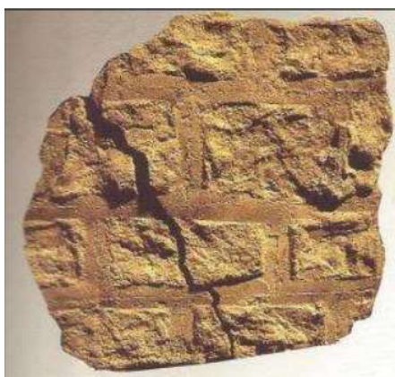
16.Kép. Faragott terméskőből rakott falazat és a fűgák lenyomata az elsőként felhordott vakolatréteg hátoldalán. Périgeaux, musée du Périgord à Périgueux. (fotó: A. Barbet, Barbet 1997, Fig. 14.).
