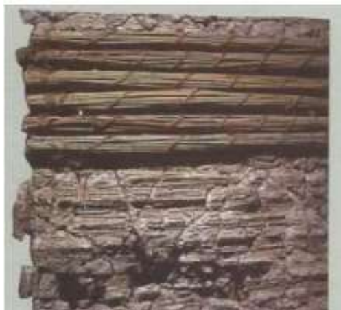
13.Kép. Nádköteg lenyomata. Peristyl ház, Narbone. (fotó: A. Baret 1997, Fig 24).
