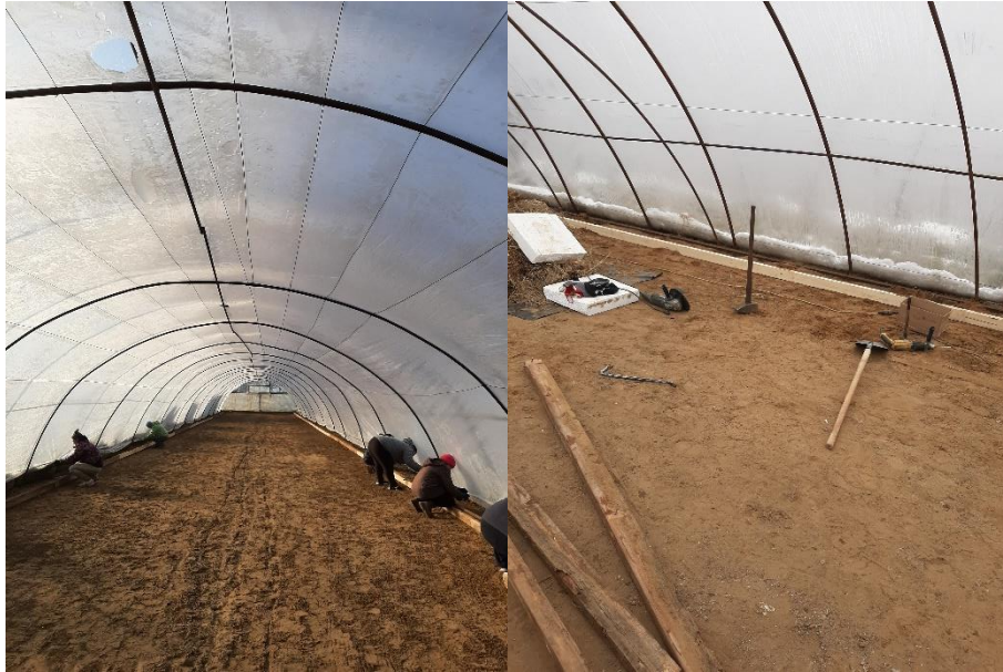
6.ábra. Fátyolfólia felhúzása, lécek cseréje
