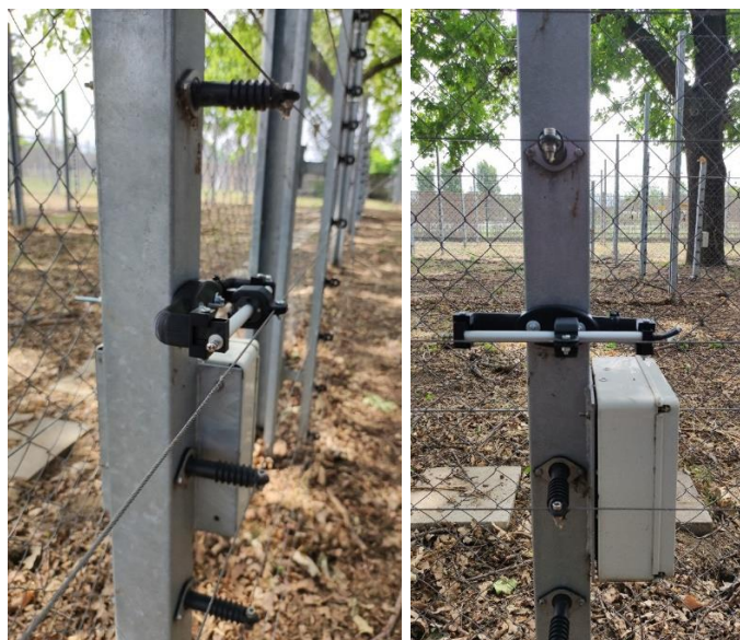
44. ábra A kerítésre helyezett szenzor oldal- és előlnézetből (saját fotó)
