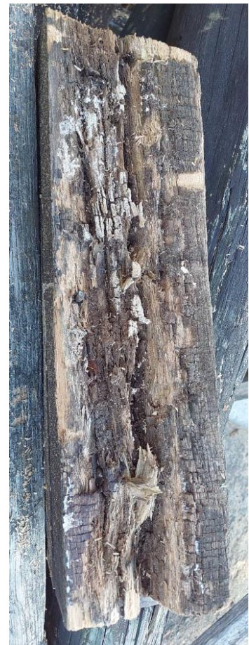
14. ábra: Korhadt szerkezeti elem [1]
