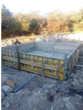
51. ábra: Az új kilátó alapozása [1]
