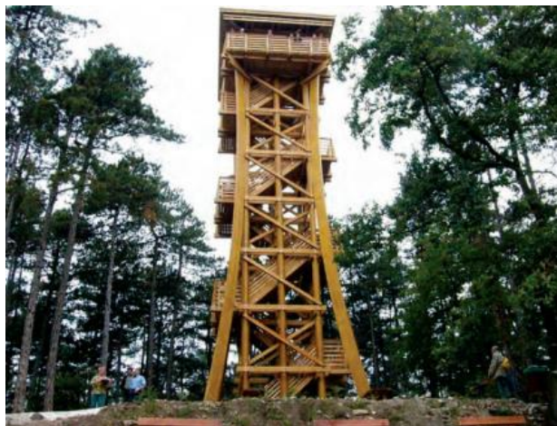
4. ábra: Sörházdombi kilátó íves RR-szerkezete [6] (Szigethy Balázs)
