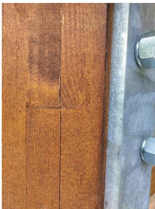
58. ábra: A lábazat delaminációja [1]
