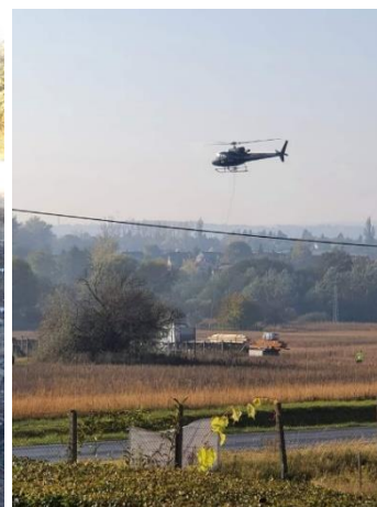
52. ábra: Az új kilátó elemeinek szállítása [1]
