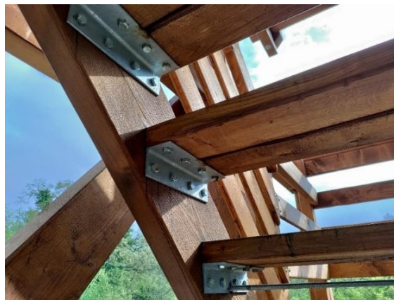
54. ábra: Az új lépcső rögzítési módja [1]
