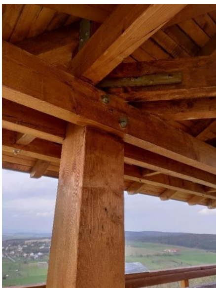
56. ábra: Lábazat csomóponti kapcsolódása a tetőszerkezettel [1]
