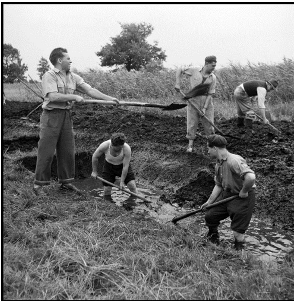
5. kép: Vízelvezető árok építése a Hanságban Forrás: Fortepan / Szalay Zoltán adományozó
