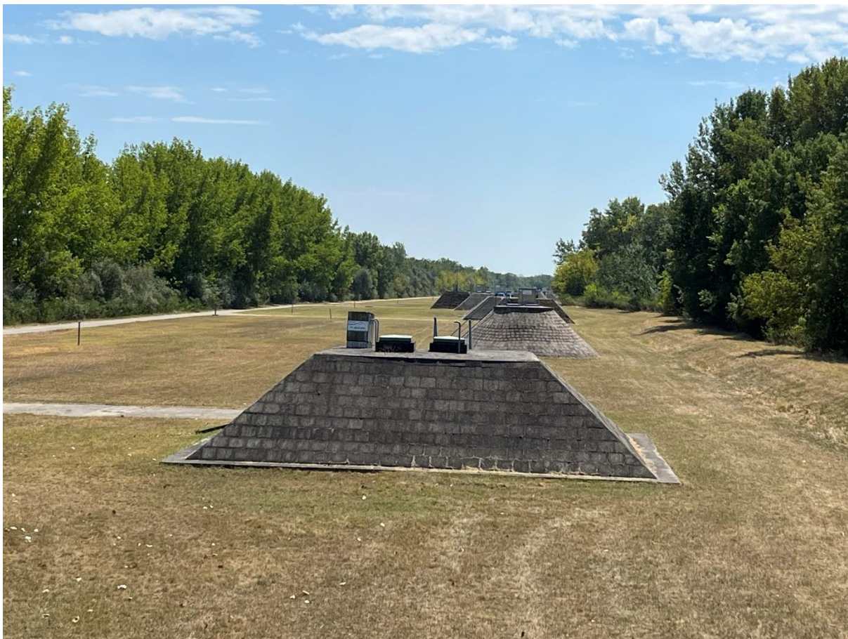
5. ábra: A vízbázis csőkút hálózata. A kép iránya párhuzamos a Dunával (É-D) (saját kép, 2022. július 27.).
