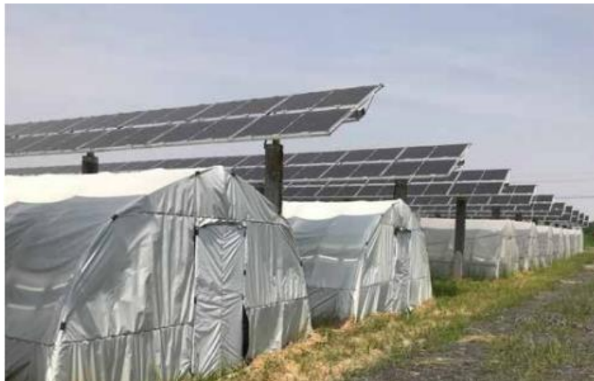
12. ábra: Fóliasátor fölé helyezett, állványos AgroPV-rendszer. Kép forrása: Fraunhofer ISE Guideline, 2020
