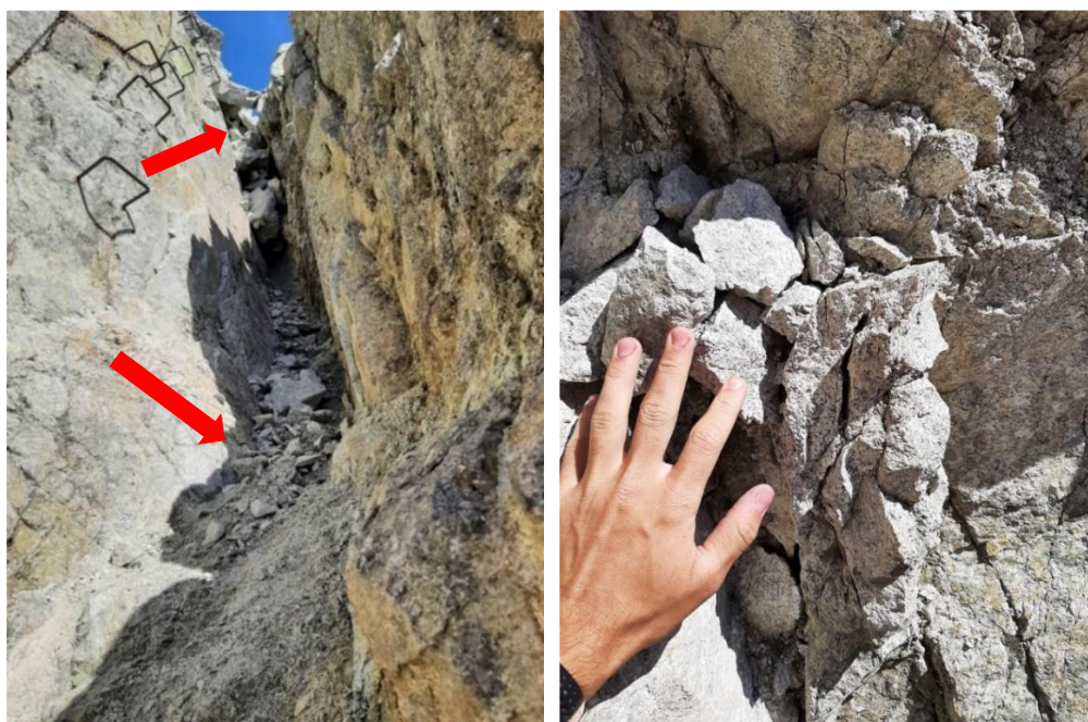
(4. kép. -balra- a Rovátka északi oldalán vezető út és a kuloár tetején lévő instabil törmelék, 5. kép. -jobbra- erős aprózódás nyomait mutató szálkő, a turistaút közvetlen közelében, a támaszkodásra/kapaszkodásra használt területen. forrás: saját felvétel)
