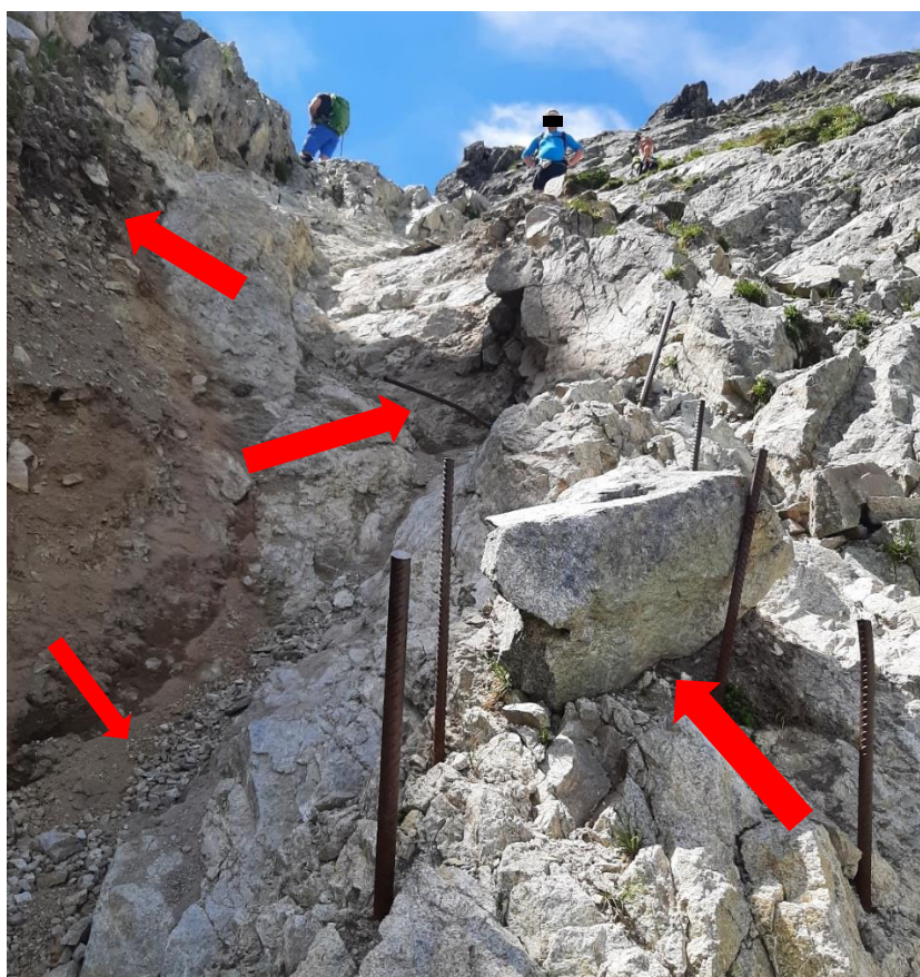
(6. kép. a Rovátka déli oldalának csúcs közeli régiója, fém megerősítésekkel. A piros nyilak mutatják a mozgó törmeléket az úton (jobb oldal két nyíl) és apró törmelékösszlettel egybetartva a falban (bal oldali két nyíl), forrás: saját felvétel)
