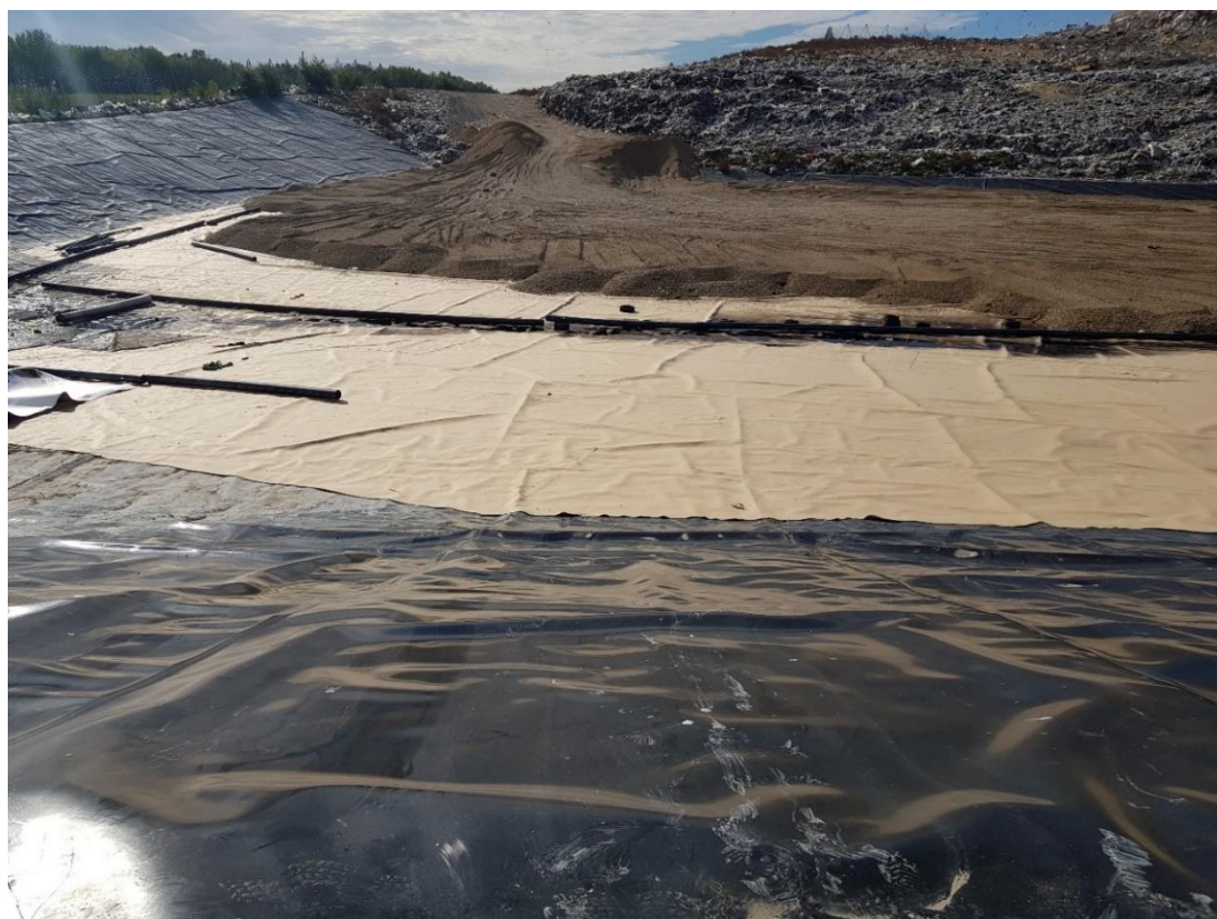
15.ábra. A szigetelés gyakorlati megvalósítása (BKM FKF, 2022)
