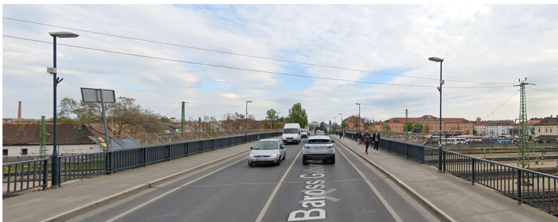
3. Baross híd (forrás: Google maps)
