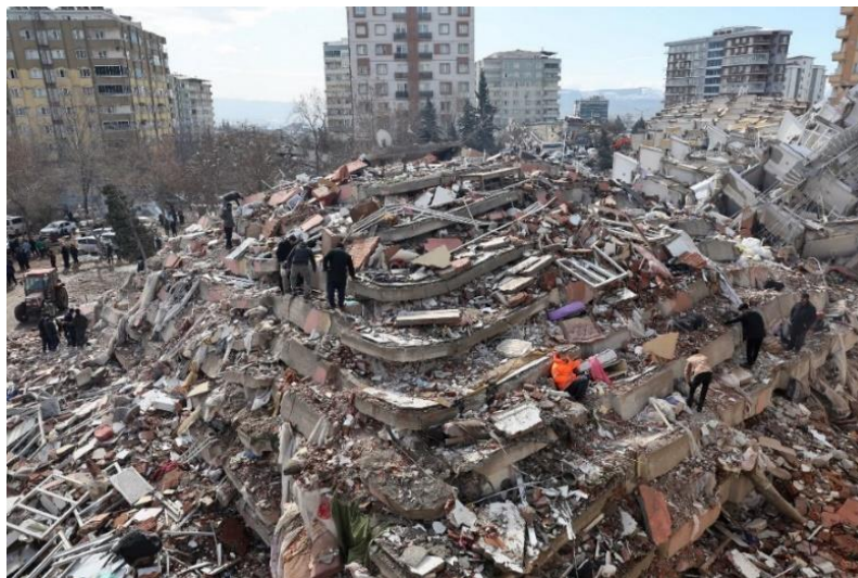
2. ábra: Kahramanmaraş városban összeomlott épület [5]
