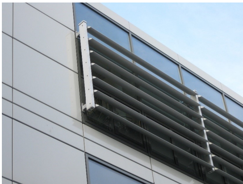
17. ábra: Forgólamellás homlokzati árnyékoló 25
