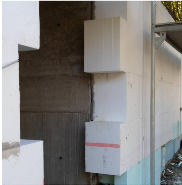
9. ábra: 38 cm vastag hőszigetelés homlokzaton 17
