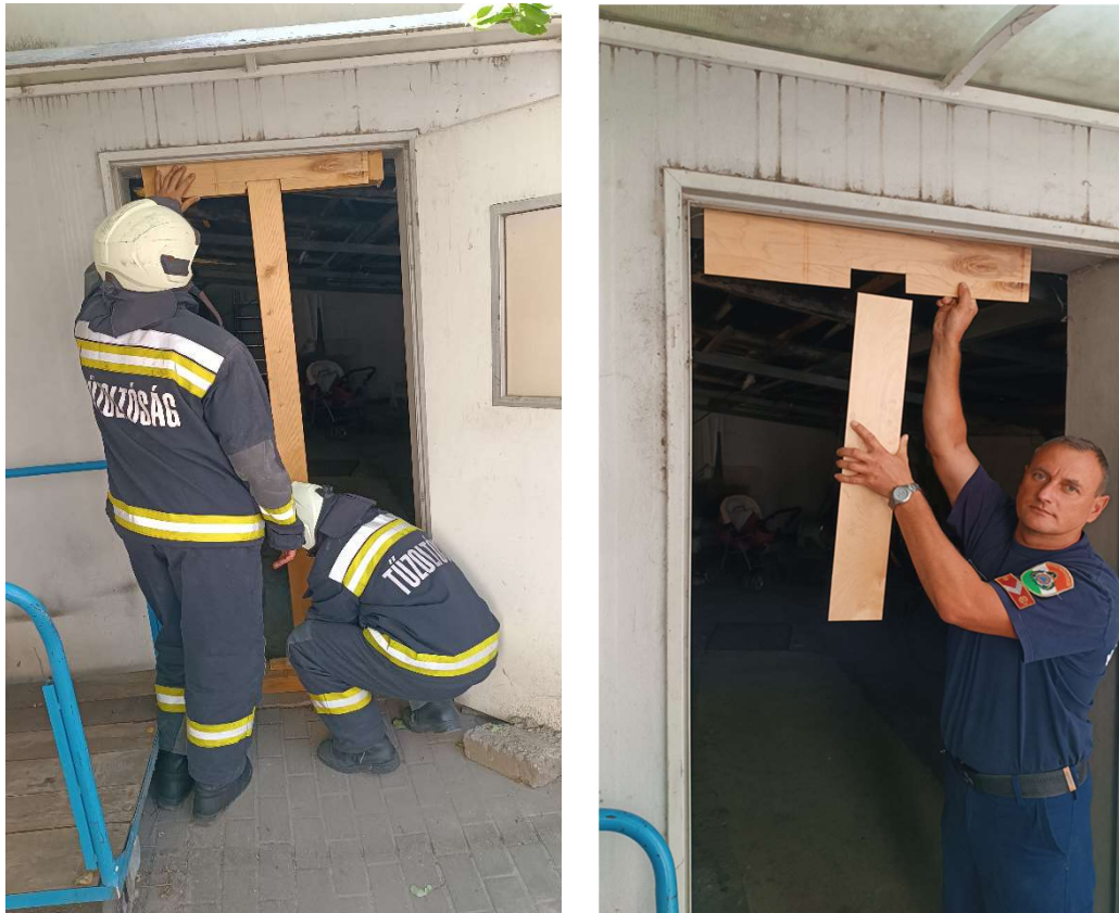
18. ábra Ajtó káva alátámasztása, egyenes beeresztéses sablon használata.
