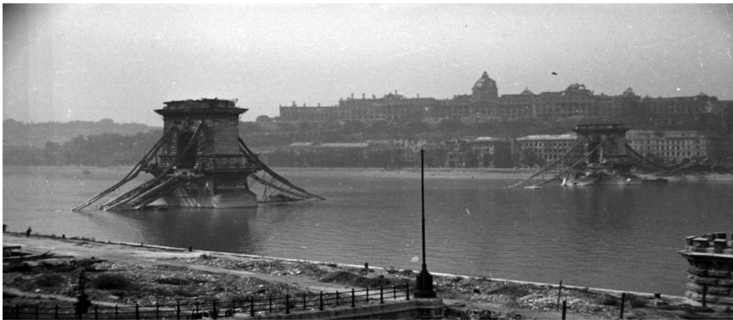
3. ábra: A felrobbantott Lánchíd [5]
