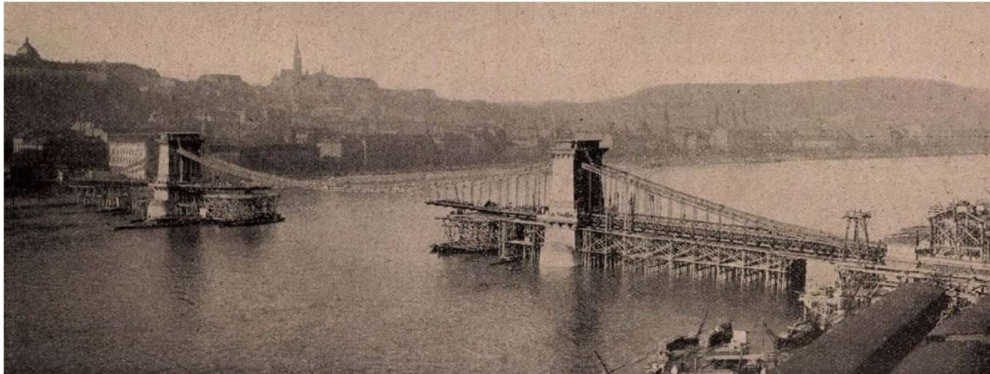
2. ábra: A Lánchíd átépítése 1913-15 között [2]
