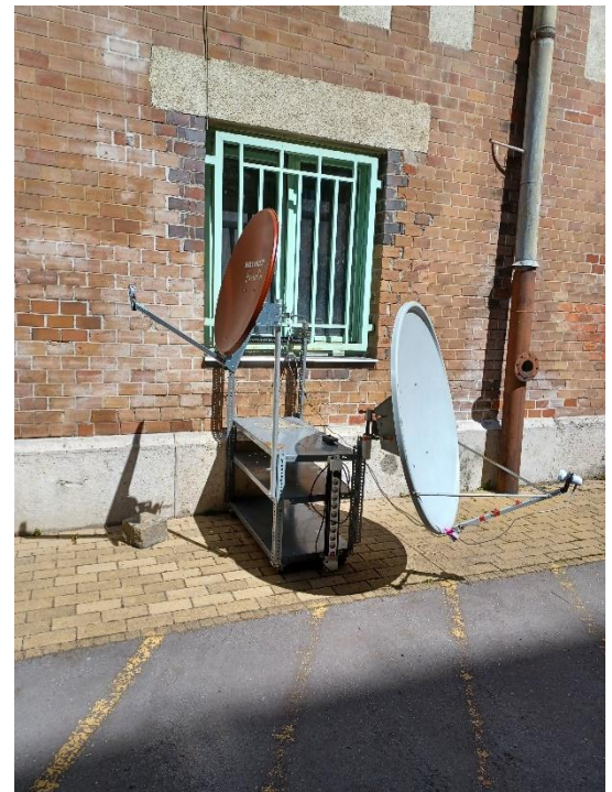
4.1 1. Ábra: Rögzített antennák
