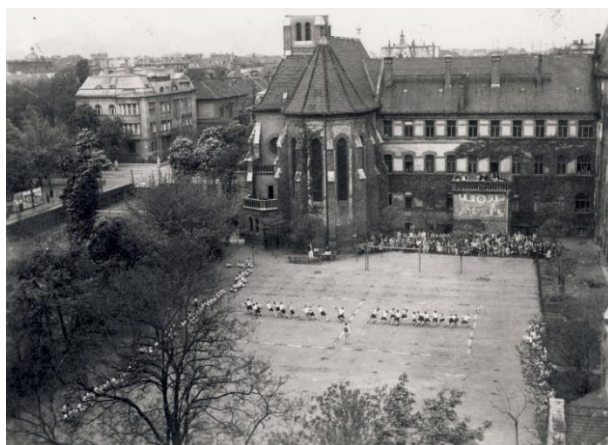
9. ábra A gimnázium udvara 1938-ban (kép forrása: Fortepan)
