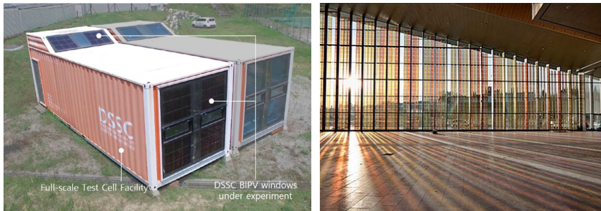
2. ábra: Festékrézékenyített napelem cella építészetbe való integrálhatósága, ahol a bal oldali ábra egy kísérleti elrendezést szemléltet, a jobb oldali ábra egy működő rendszert ábrázol, ahol az ablakok előtt elhelyezkedő színes ablak üvegek a festékrézékenyített napelem cellák [46].
