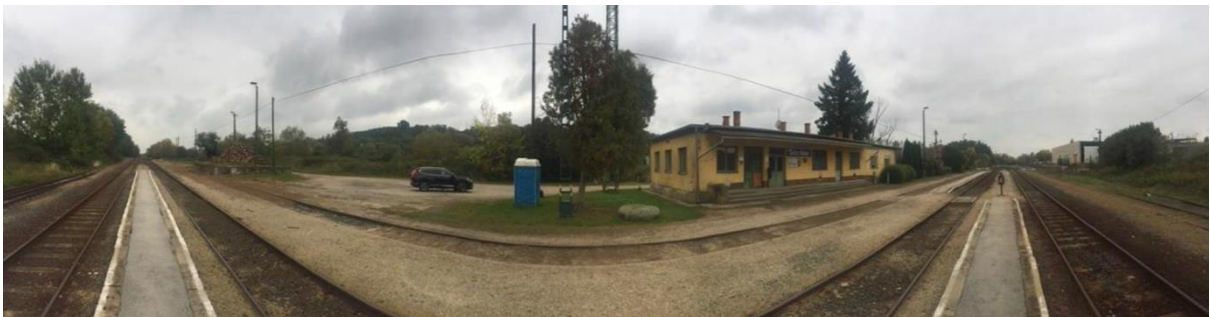
12. ábra - Gutorfölde állomás (forrás: saját fotó)
