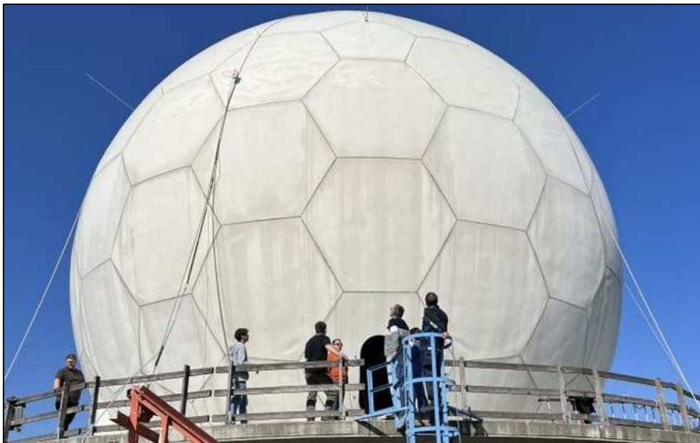
40. ábra: Püspökladányi légtérellenőrző radar és a mikrosztrip mérőantenna
