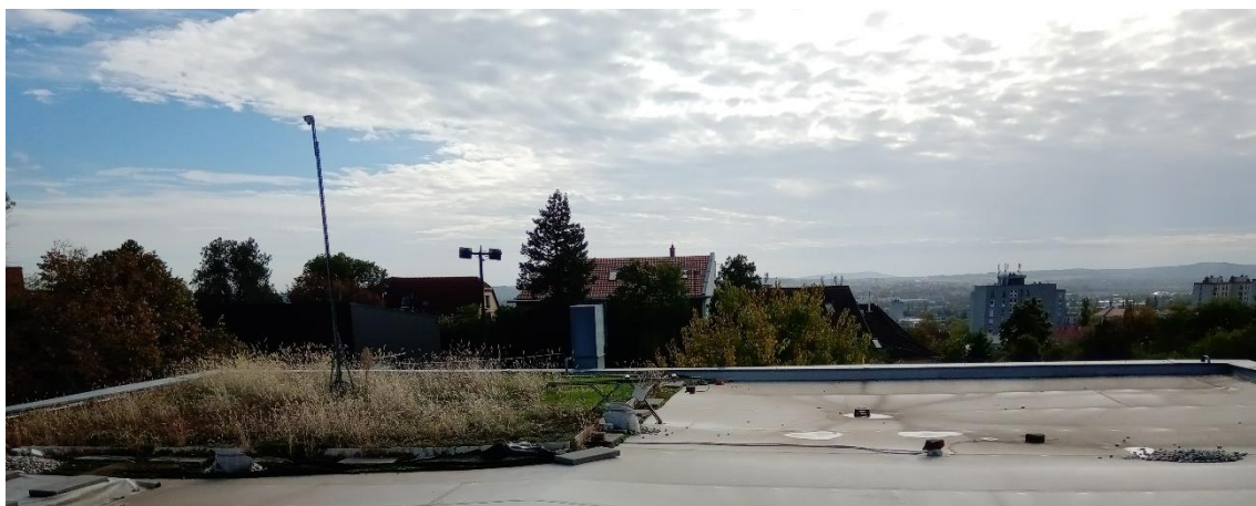
3.1. ábra. Extenzív zöldtető és kontrolltető a Pécsi Tudományegyetem Műszaki és Informatikai Kar "C" épületének tetején (Készítette: Gáspár Bernadett 2023.11.07.)
