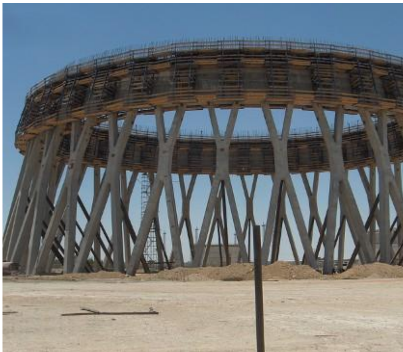
16. kép: A köpeny indításának kizsaluzása (doka.com, 2022)
