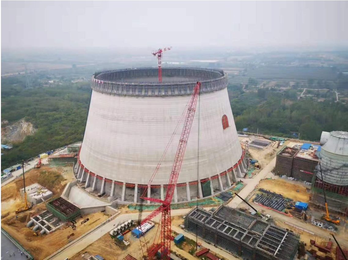
17. kép: Toronydaru elhelyezkedése a torony közepében (doka.com, 2022)
