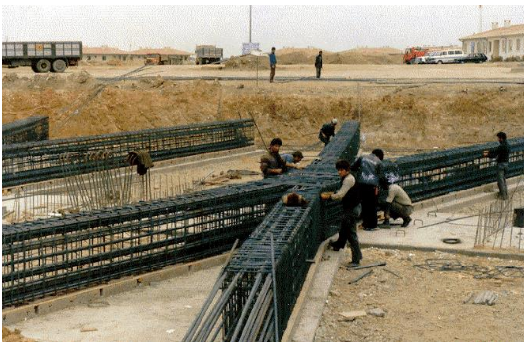
14. kép: Az "X" lábak vasszerelése vízszintes helyzetben (Törökország, Dr. Pálfalvi Dóra, 2016)
