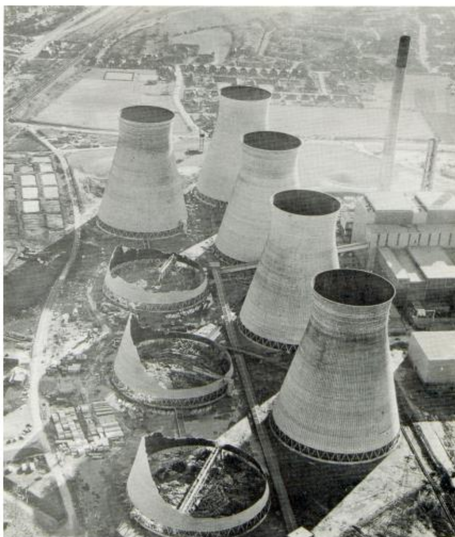
22. kép: A Ferrybridge-i hűtőtornyok látképe a katasztrófa után (google.com, 2022)
