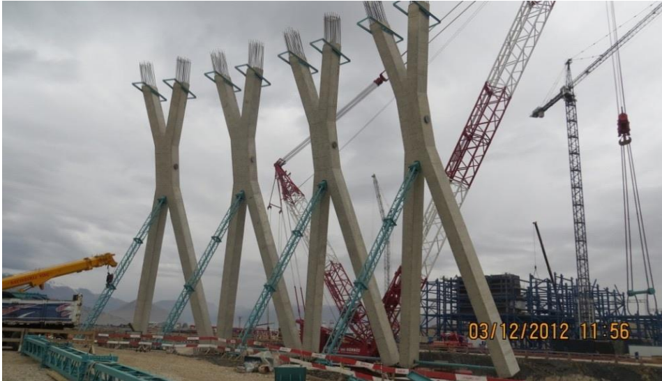
15. kép: "X" lábak a végleges helyzetükben (Törökország, Dr. Pálfalvi Dóra, 2012)
