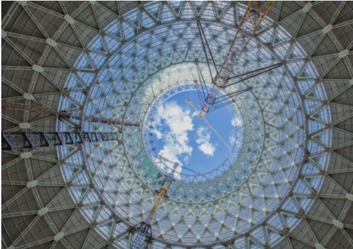
7. kép: Acél szerkezetű hűtőtorony háromszög hálózata (Xilinhaote, Dr. Pálfalvi Dóra, 2012)
