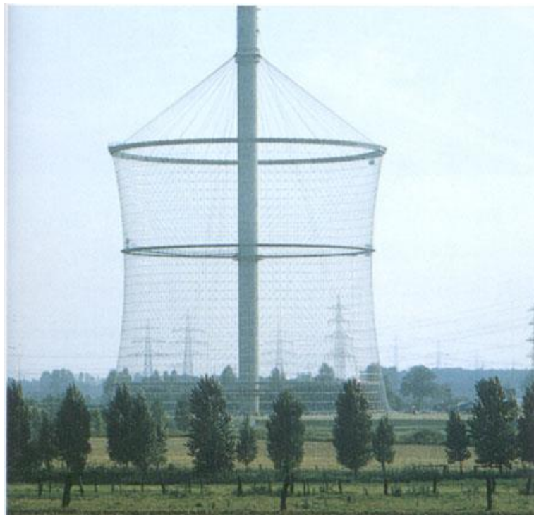
13. kép: Megépült kábeltorony, még burkolat nélkül (Németország, 1992)
