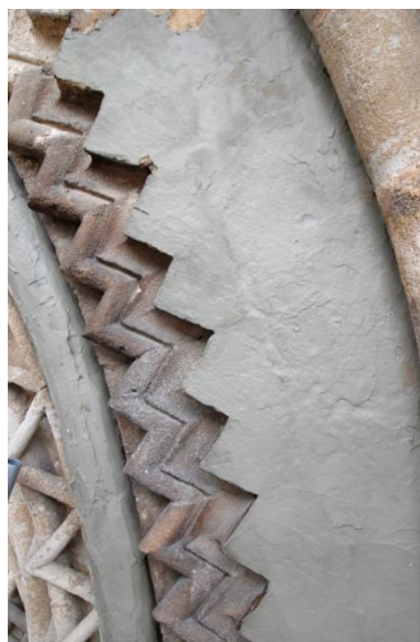
9. kép: A kőfelületre felhordott pakolás (Ják, Szent György bencés apátság, Nyugati kapu, déli béllet)
