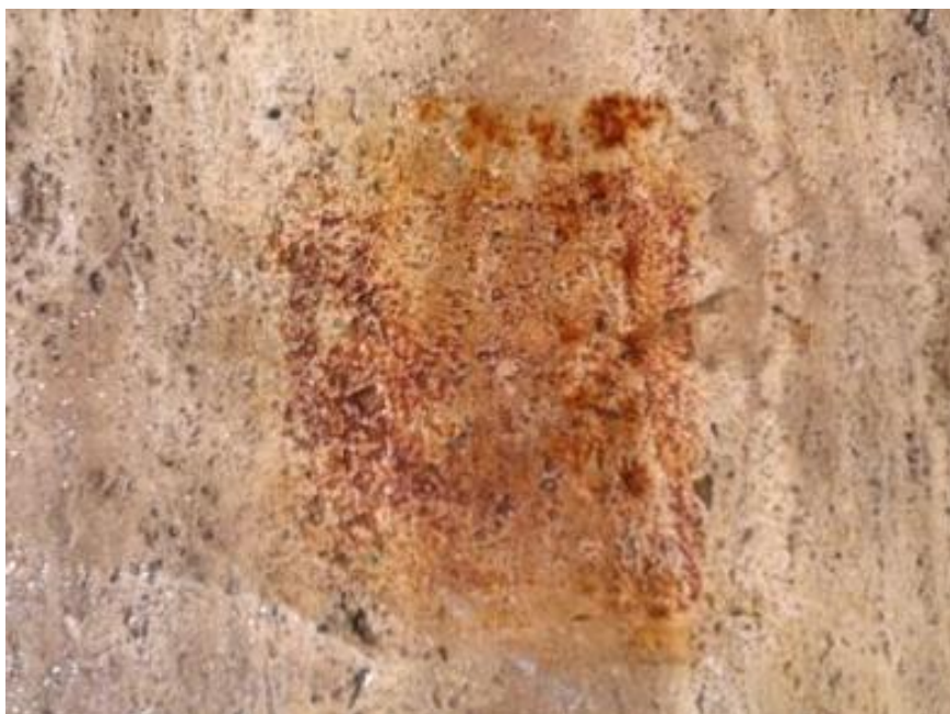
18. kép: Külső forrásból származó vasszennyeződés a kő felületén
