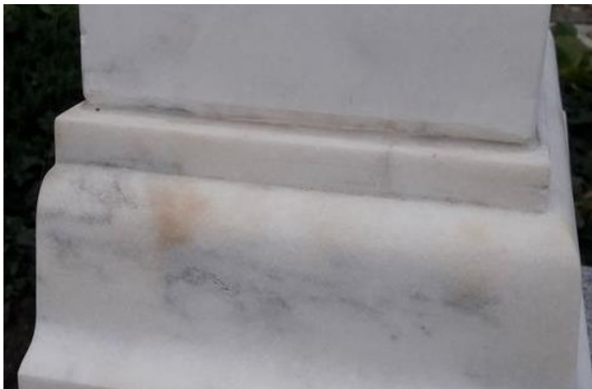
17. kép: A márvány anyagában jelenlévő pirit kioldódása
