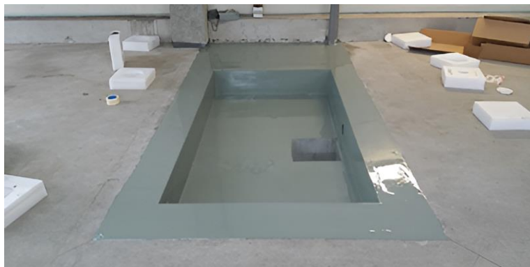
9. ábra: Talajba süllyesztett kármentő 19
