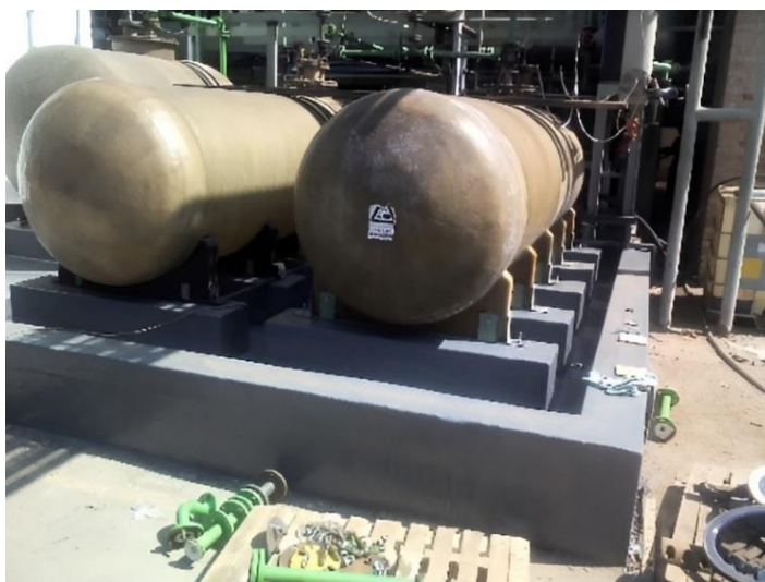
10. ábra: Földfeletti kialakítású kármentő 20
