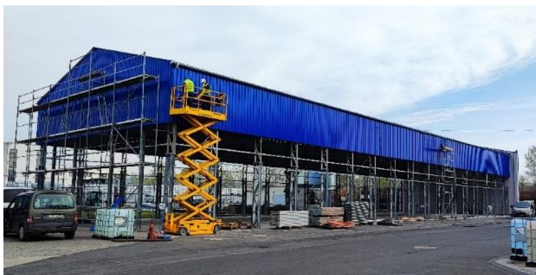
5. ábra: A tűzveszélyes áru raktár felépítésének kezdeti állapota [saját kép]
