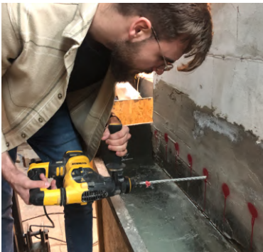
8. ábra: Furatolás kivitelezése
