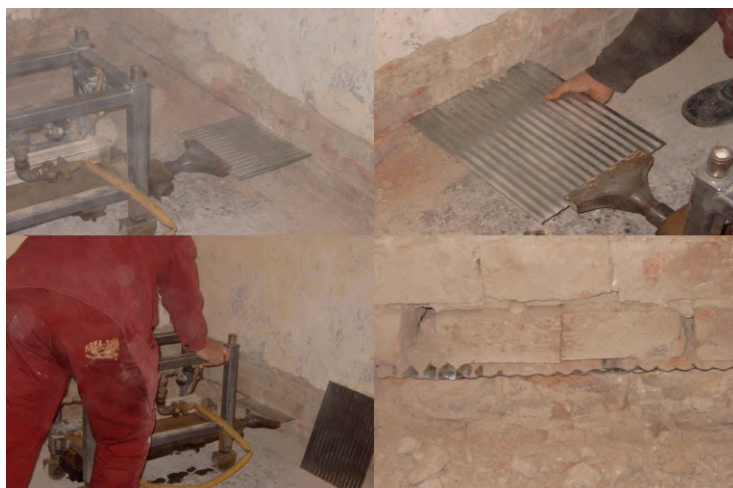
63. ábra: Acéllemez beverésének kivitelezési fotói (26)
