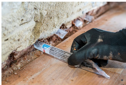
69. ábra: Fagyasztott vegyianyag rudak behelyezése furatba (28)
