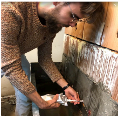
66. ábra: Injektálókrém alkalmazása
