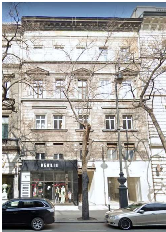
30. ábra: Az épület jelenlegi homlokzata az Andrassy út felől
