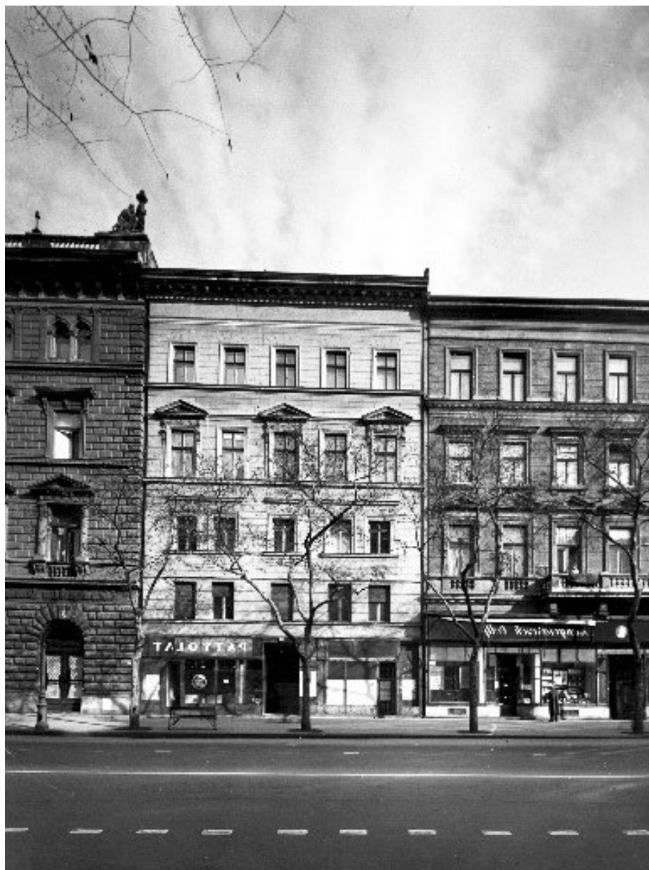
29. ábra: A második világháború utáni átépítés következtében létrejött homlokzat
