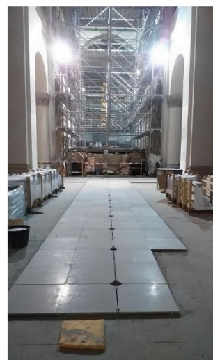
11. kép kivitelezés közben készült kép a főhajóban
