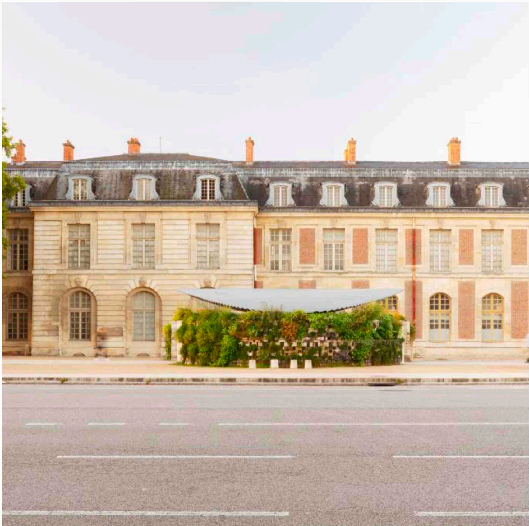
BAP! pavilion, Versailles, 2022, chaltier dalix architectes
