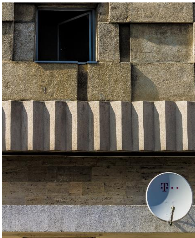
13. kép: A földszintet és az első emeletet elválasztó barázdált párkány.
