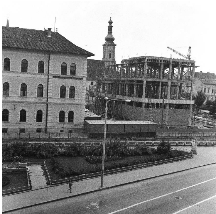
7. kép: A Telefonpalota építés alatt.
