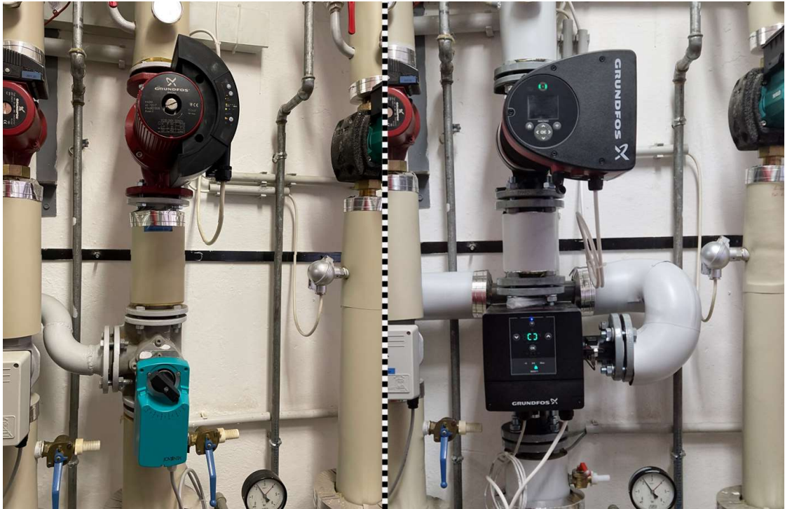
7. ábra A keverőkör átalakítás előtt és után
