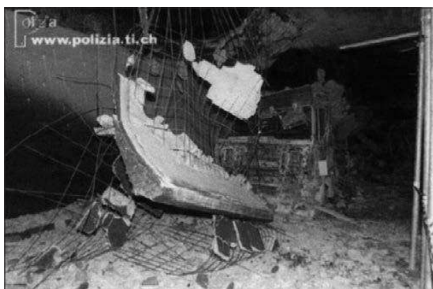
1. ábra: Gotthárd alagút betonfelületének réteges leválása (polizia.ti.ch, 2008)
