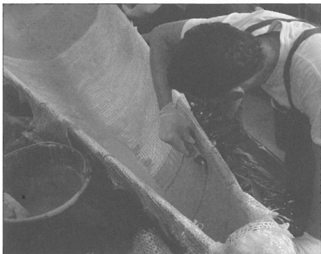
5. ábra: Betonréteg felhordása az üvegszövetre
