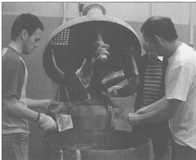
4. ábra: A betonkeverék elkészítése
