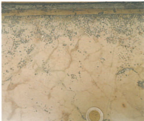
12. ábra: Egykor érdesített felület lekopása
