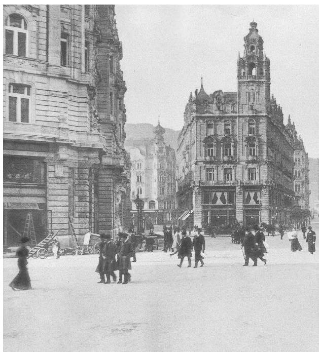
11. „Az 1902-ben épült Klotild paloták a Kígyó, illetve az Eskü út sarkán. Háttérben az épülő Erzsébet híd.”
