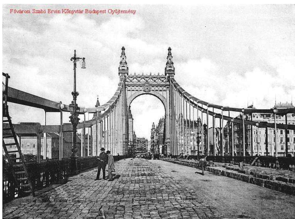
17. Zsigmondy Béla (1848–1916) gépészmérnök, hídépítő, Az épülő Erzsébet híd, 1903. szeptember 26.
