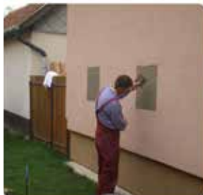
2. ábra: Higrotermikus monitoring rendszer kialakítása a hajdúnánási hőszigetelt családi ház dél-keleti homlokzati hőszigetelésében
