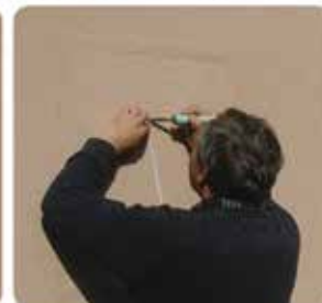
2. ábra: Higrotermikus monitoring rendszer kialakítása a hajdúnánási hőszigetelt családi ház dél-keleti homlokzati hőszigetelésében
